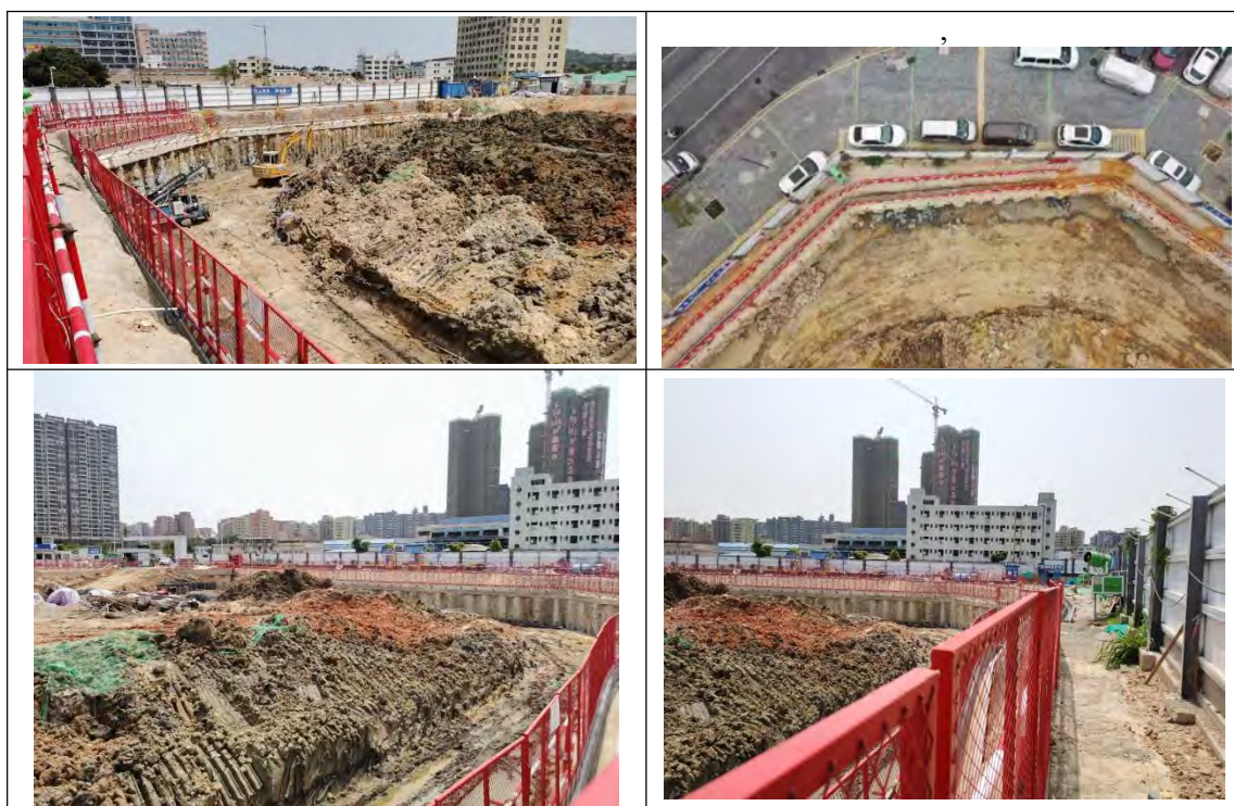
图 3-2 地块现场踏勘照片
