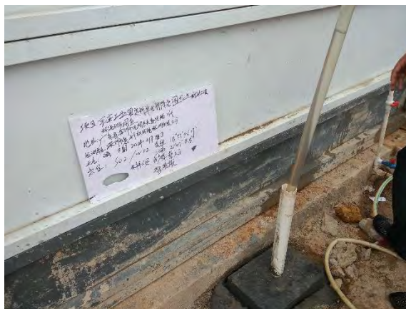
W2监测井建井后洗井
