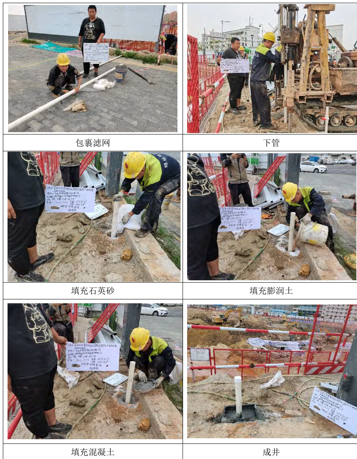
图 4-6 监测井建井过程
