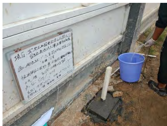
W1监测井建井后洗井
