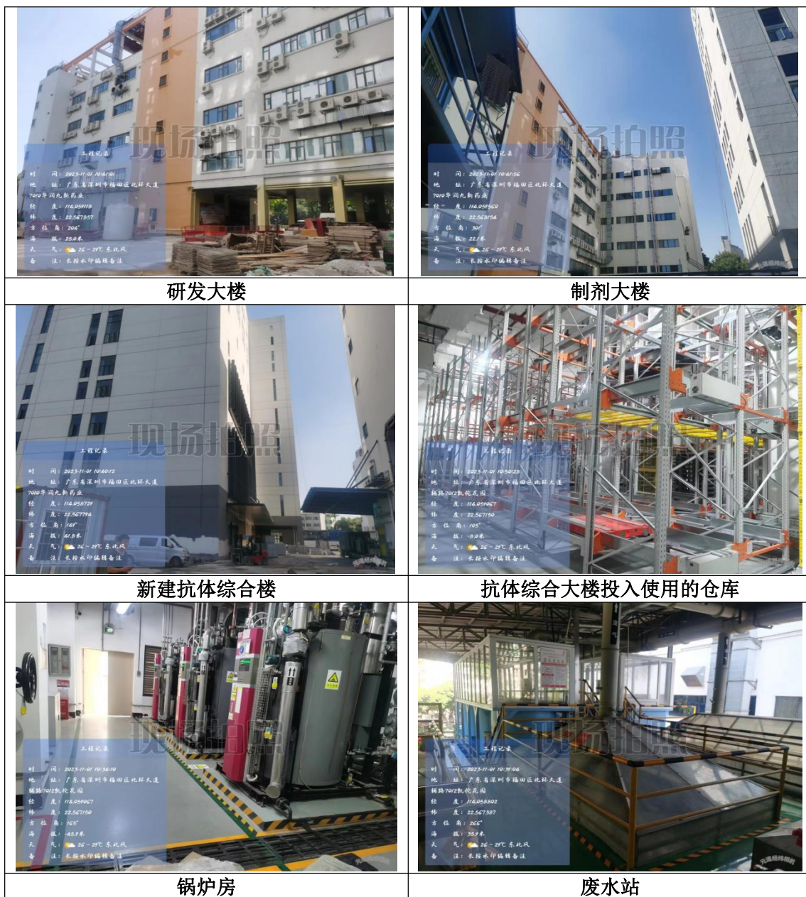
附图4 现场踏勘照片
