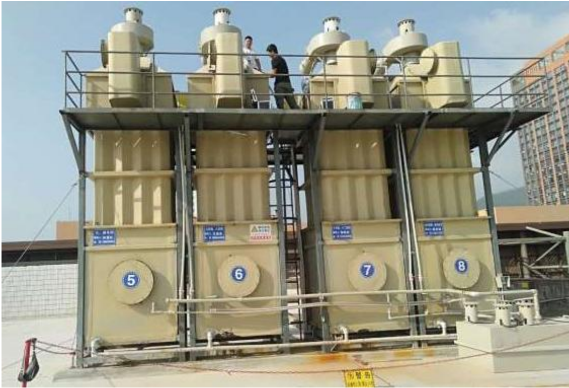
废气处理净化设施及取样平台
